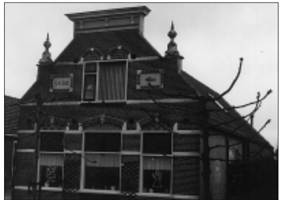
Het pand aan de Bloemendaalseweg onder Waddinxveen waar jarenlang Herberg 'De Oude Baars' was gevestigd.
