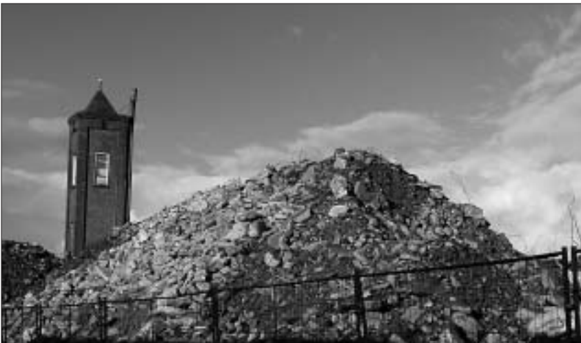
Leegstaande gebouwen van de Plateelbakkerij 'Zuid-Holland' (PlaZuid) worden afgebroken. Foto's: Jan H. Kompagnie.
