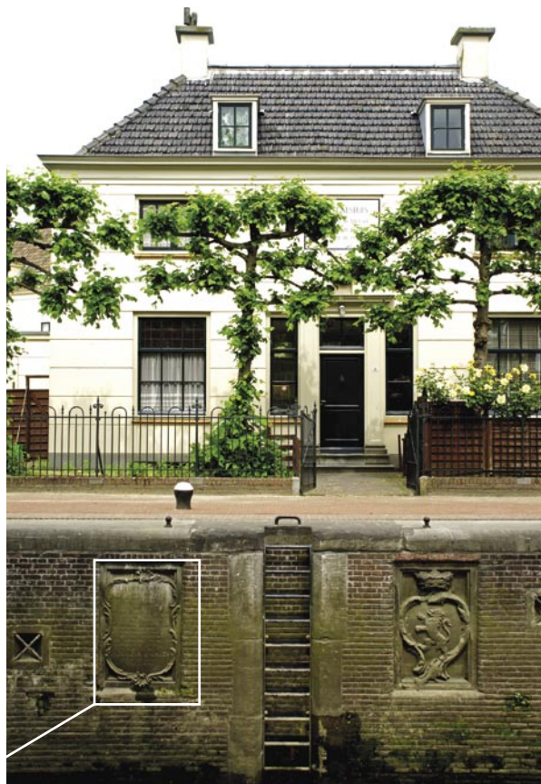
De Mallegatsluis met links de herdenkingssteen uit de Herrinneringen (Foto: C. de Keizer, Empire Imaging)
