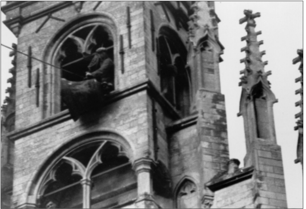
De klok 'Gabriël' wordt uit de toren van het stadhuis verwijderd. Foto: SAHM.
