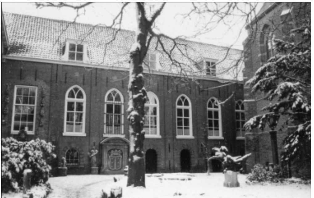
Verbinding tussen de voor- en achterbouw van het gasthuis. Foto: SAHM.
