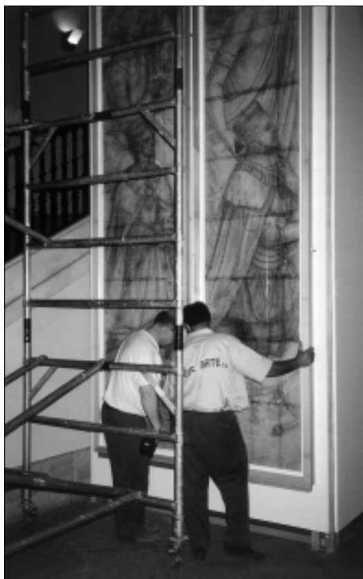
Het plaatsen van de panelen.
