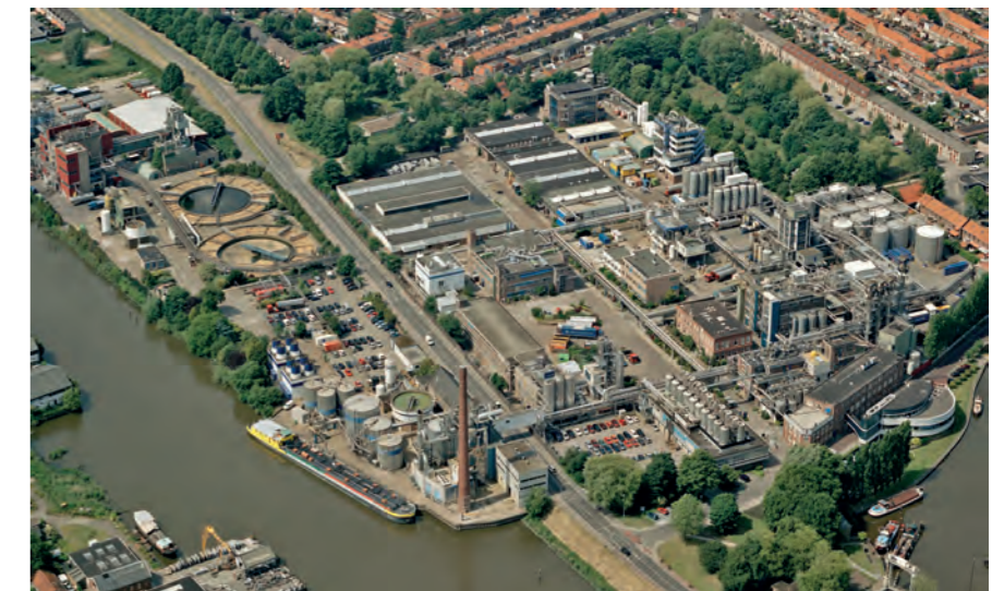
Luchtfoto van de fabriek gelegen aan de rand van de wijk De Korte Akkeren. (foto: Collectie Croda)
