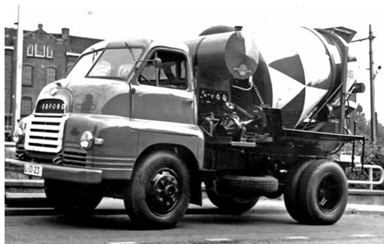
De eerste betonmixer, Gouda 1959 (fotoarchief Gerard van Nieuwpoort)
