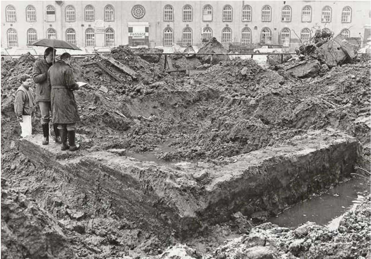
Opgraving van de fundering van het kruithuis aan de vooravond van de nieuwbouw aan de nieuwe markt. Het vierkante formaat van 4.80 meter bij 4.80 meter lijkt hier aanwezig te zijn.(foto: collectie M.van Dasselaar)
