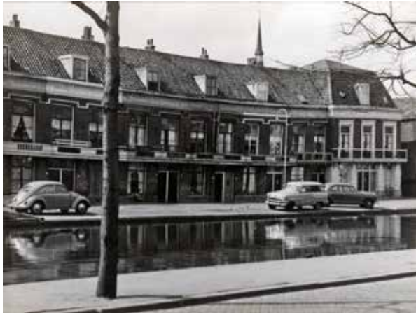
Waarom het blok met woningen de bijnaam De Rodelbaan kreeg blijkt uit deze foto (foto: SAMH 55896)
