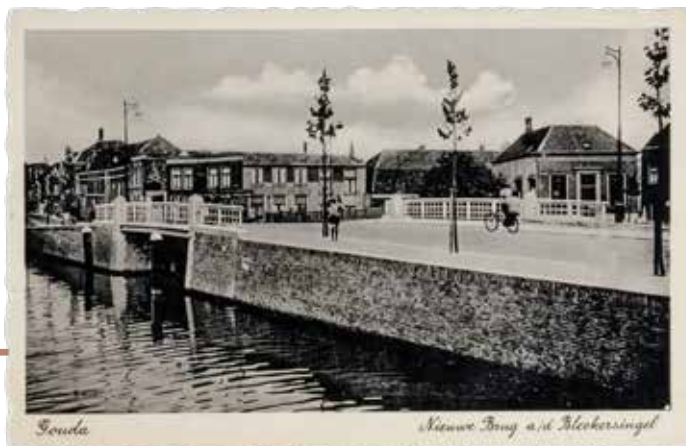
Gouda Nieuwe Brug aan de Blekerssingel De nieuwe brug aan de Blekerssingel op de hoek van de Karnemelksloot. ca. 1940 (SAMH 0440. 54652)
